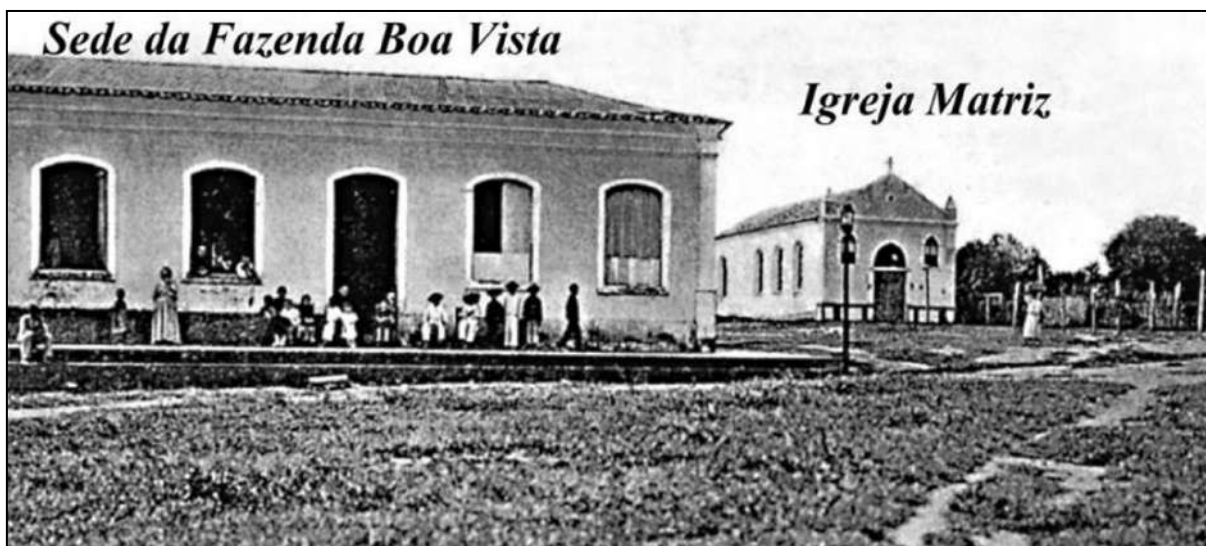
Figura 4: Sede da fazenda Boa Vista ao lado da Igreja Matriz em 1905.
