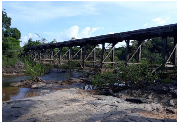
Figura 13: Área abrangida pela ponte sobre o Rio Urubu que interliga Vila Vilena à Comunidade Indígena Água Boa no município de Bonfim, Roraima.
