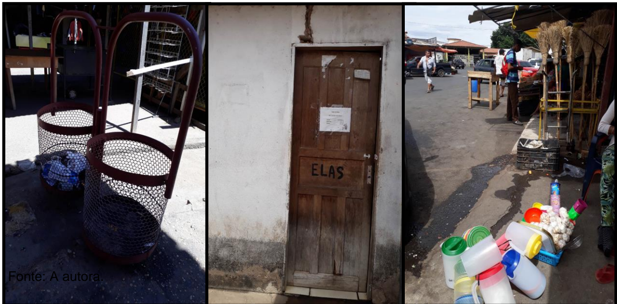
Figura 04: Lixeiras inadequadas, banheiros precários, descarte incorreto do lixo, problemas de infraestrutura na Feira do Produtor Rural
