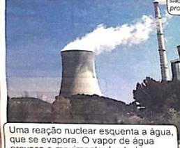
Uma reação nuclear esquenta a água, que se evapora. O vapor de água provoca o movimento das turbinas.
