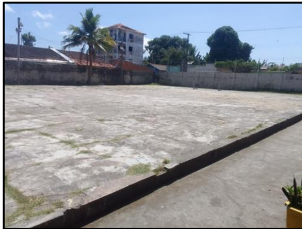
Fotografia 2– Estrutura da Escola
