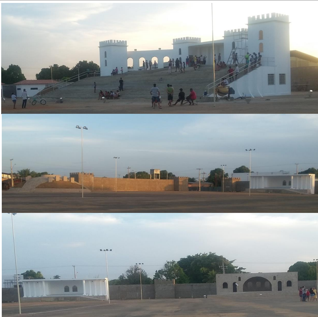
FIGURA 5 - Cenário da Paixão de Cristo em construção FONTE: Acervo da autora, (2017).
