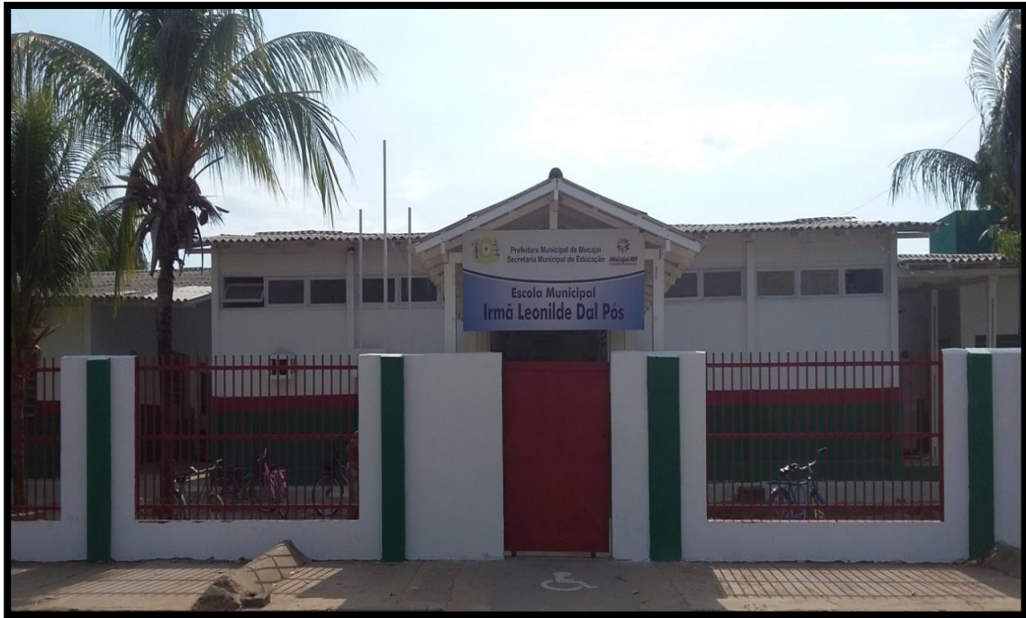
FIGURA 14 - Entrada da escola municipal Irmã Leonilde Dal Pôs FONTE: Acervo da autora (2016)
